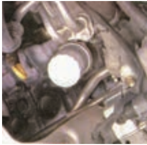
شکل (۲-۶۰) کنترل فیلتر از نظر نشتی
